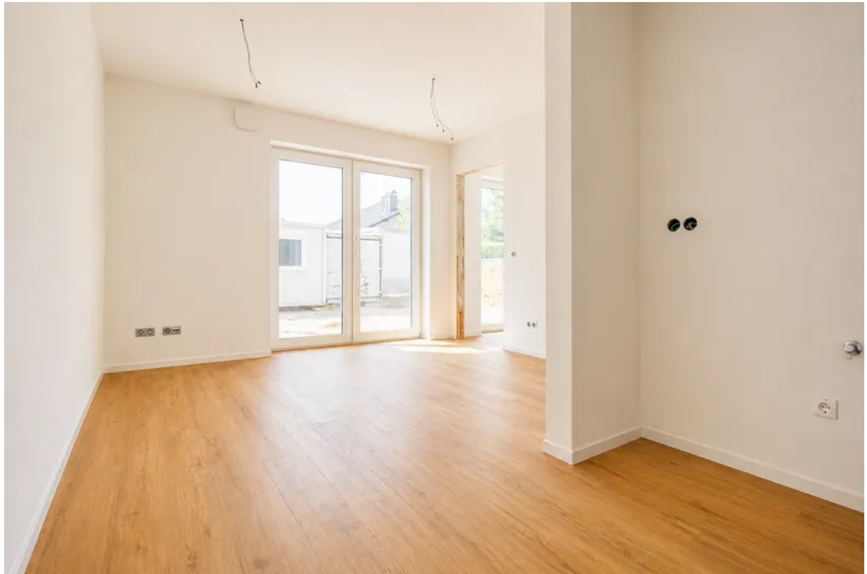
Blick Wohnen von Küche aus
